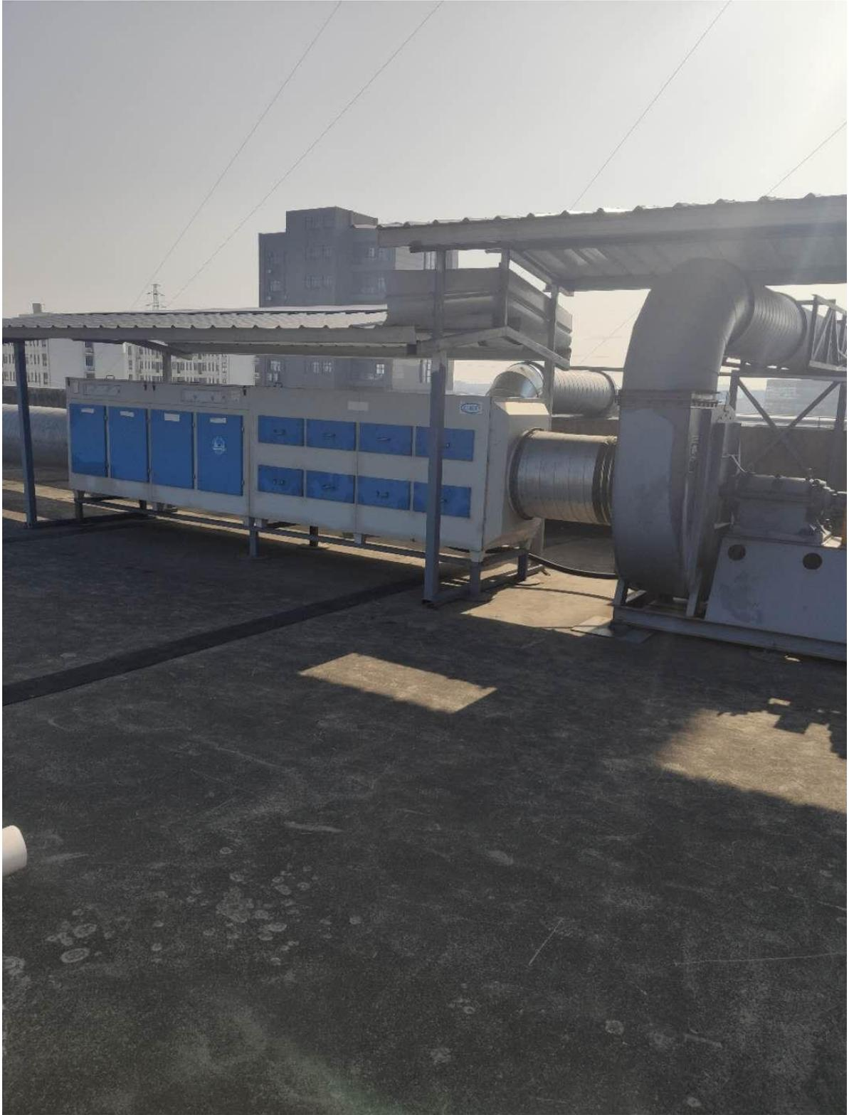
图 4-1 本项目排气筒废气处理设施照片
